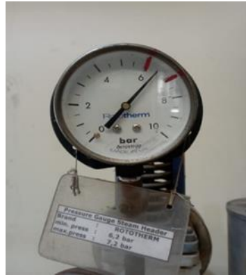
Gambar 7. Pengecekan pressure HD pipa.
