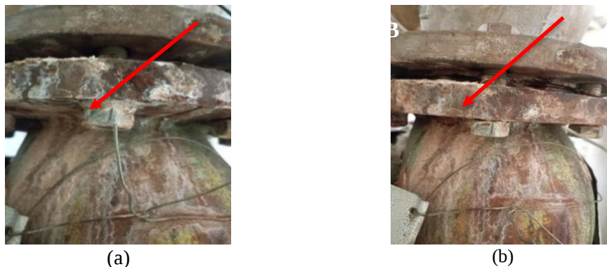
Gambar 4. Dokumentasi baut pada flange (a) sebelum dan (b) sesudah penerapan preventive maintenance
