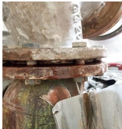
Gambar 1. Flange pada pipa steam .
