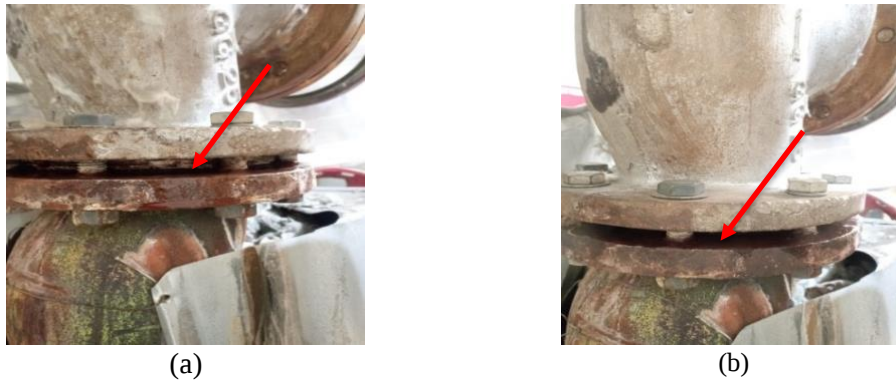
Gambar 3. Dokumentasi flange (a) sebelum dan (b) sesudah preventive maintenance .
