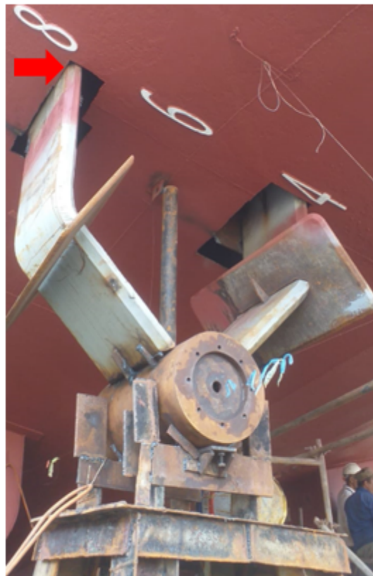
Gambar 1. Proses pemasangan braket V poros propeller kapal
